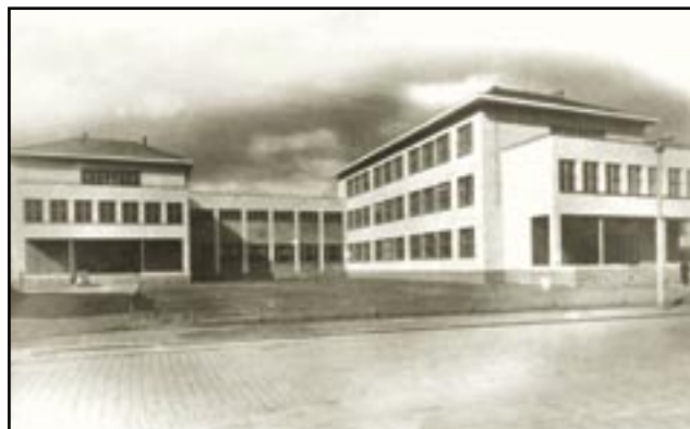
Nové školy těsně po dokončení v roce 1938 (z archivu základní školy)
