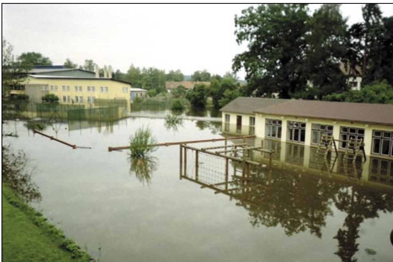
Při povodni v roce 2002 přízemní prostory školy zaplavila řeka Lužnice (z archivu autora)
