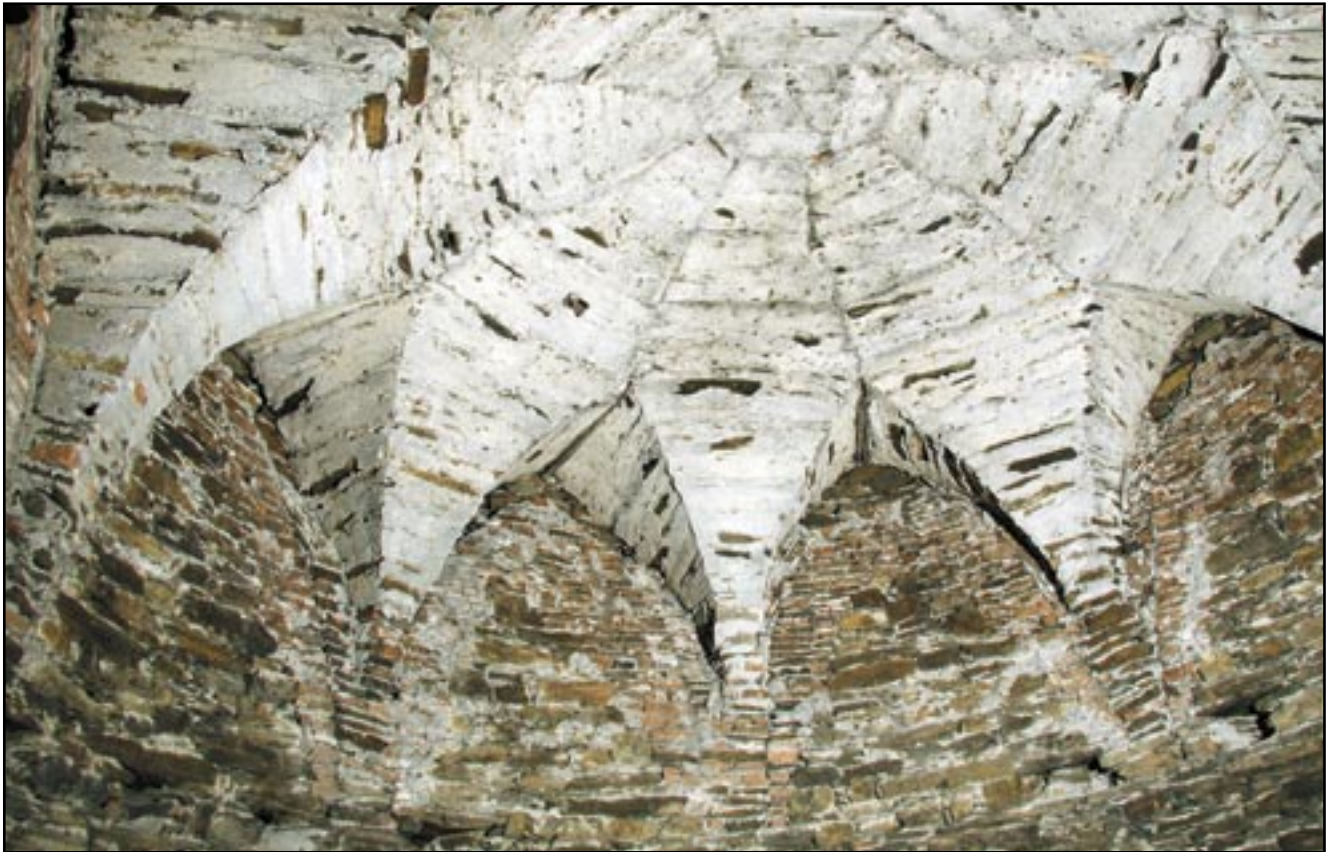
Přízemní prostory soběslavské Hlázky s pozoruhodnou pozdně gotickou hvězdicovou klenbou budou zpřístupněny veřejnosti (foto Luboš Tíkal 2010)
